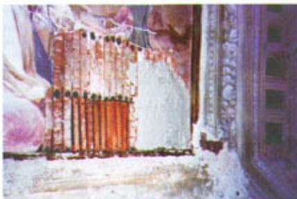
5. Integrazione in malta della lacuna, previa esecuzione di saggi per la composizione di malte idonee per colorazione e granulometria e successiva lavorazione superficiale (AG 2). Equilibratura cromatica dell'integrazione con l'originale mediante successive velature di colore con pigmenti minerali legati con caseinato d'ammonio (AG 3)
