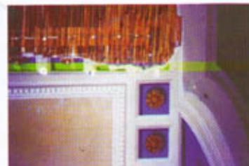
5. Posa in opera di soffitto a cannuce assicurate con filo di ferro zincato da 1 mm, raccordato con l'orditura esistente mediante viti in ottone sottolivello. Particolare della connessione del nuovo soffitto in cannuce con l'esistente; in primo piano le viti in ottone con rondelle di raccordo con l'orditura sottostante.
