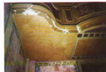
6. Stesura di intonaco, in tre strati a base di calce aerea e sabbia fluviale, in corrispondenza della zona del rifacimento, così come da analisi chimico-fisiche. Stesura ad affresco di velatura a base di calce pigmentata con terre naturali in tono con la campitura di fondo.
