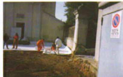
2. Rimozione del pavimento in asfalto, demolizione del sottofondo e scavo con mezzi manuali e meccanici del terreno fino ad una profondità di circa 50 cm, compreso il livellamento e lo spianamento del terreno. Posa in opera di tessuto non tessuto
