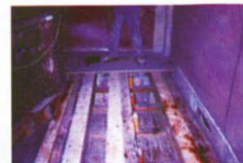
7. Rimozione accurata del tavolato di calpestio esistente e posa in opera di travi in legno lamellare, di sezione opportunamente calcolata e innestate nella muratura d'ambito. Posa in opera di nuovi travetti e angolari d'integrazione, raccordati con l'orditura esistente mediante chiodatura.
