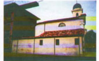
3. Prospetto Sud: consolidamento strutturale mediante inserimento di tiranti e barre di acciaio, rimozione dei rappezzati di intonaco cementizio e stesura di intonaco a base di calce e sabbia
