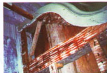
4. Crollo di porzione del soffitto in cannuce per marcescenza; agganci e fissaggi. Risulta a vista la struttura lignea sottostante.
