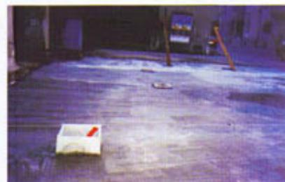
4. Posa in opera di massetto in cls completo di relative pendenze per il corretto convogliamento delle acque meteoriche
