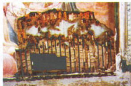
4. Rimozione manuale, tramite piccoli martelli e scalpelli, dell'intonaco cementizio posto quale rappezzo sulle cantinelle (AS 3). Integrazione delle cantinelle mancanti con elementi simili agli originali (AG 7)
