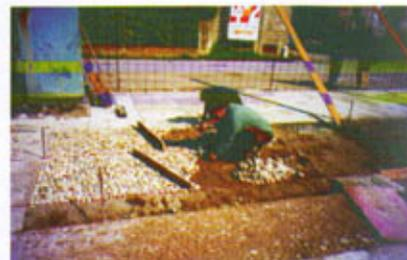
5., 6. Posa in opera e resa finale della pavimentazione in lastre di trachite euganea e in ciottoli di fiume di natura calcarea, disposti a mano su fondo in legante e sabbia e finiti con fugatura a secco
