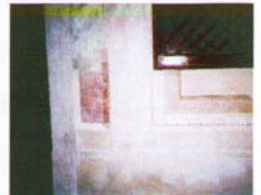
4. Prospetto interno, lato ingresso: descialbo manuale della zona sottostante ad affresco; consolidamento superficiale e in profondità dell'intonaco
