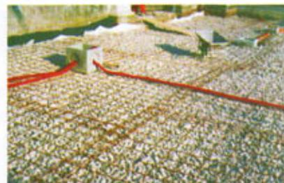
3. Posa in opera di vespaio in ghiaia per uno spessore di 20 cm e di rete elettrosaldata. Reintegrazione dei sottoservizi
